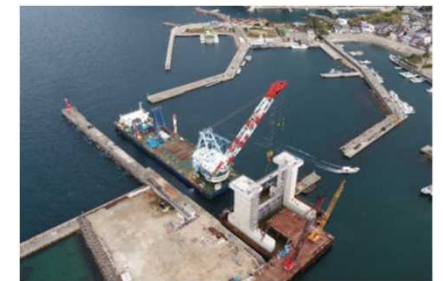
沼島漁港 水門整備
