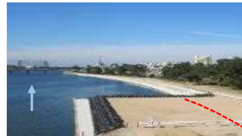
武庫川の河川改修 (赤点線：改修後の護岸の位置)
