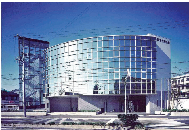
神戸市長田区に構える本社ビル
