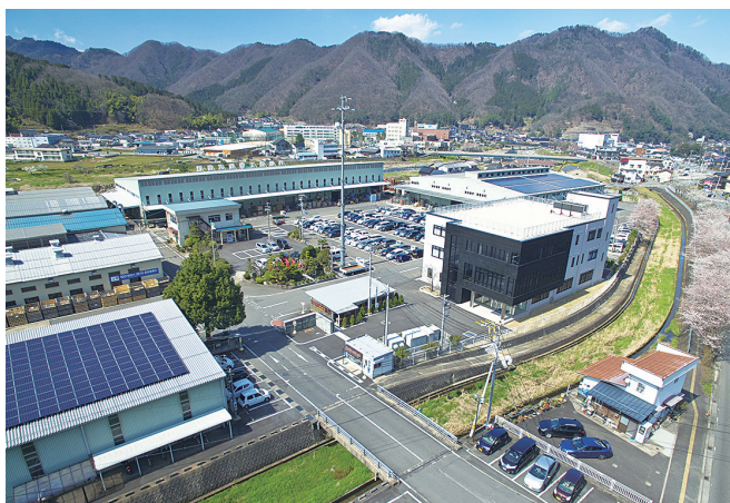
事務所は、2018年7月に竣工
