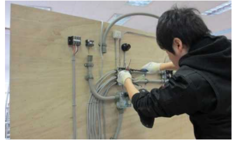
【電気配線実習】
