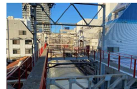
アーケード改修（屋上歩廊修繕）
