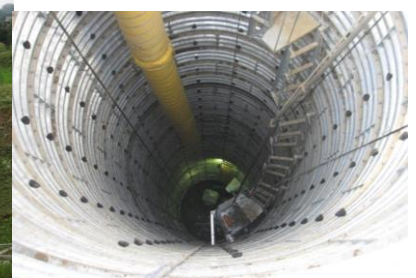
地すべり対策施設（集水井）の見学（左：外観、右：中の様子） （板仕野地域）
