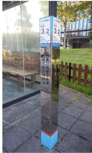
既設の台風23号浸水標柱41本及び市内の主な公共施設の避難所表示板に「地点標高」表示板を新たに設置
