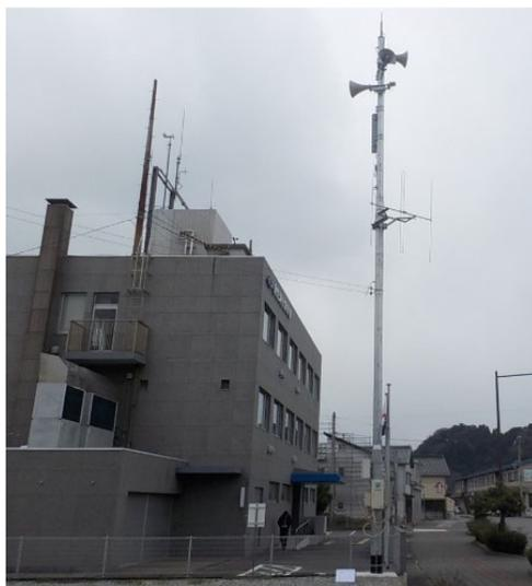
防災行政無線デジタル化工事により、屋外拡声子局を町内に8基整備を実施。防災行政のデジタル放送の本格稼働を行う。
