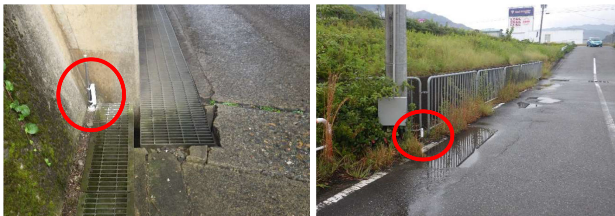
ワンコイン浸水センサーの設置（朝来市）
