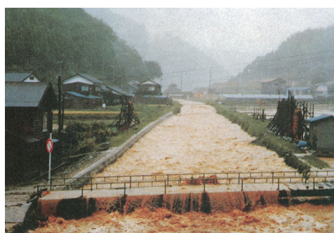
香住町（当時）餘部の橋梁を 越流する西川の増水状況
