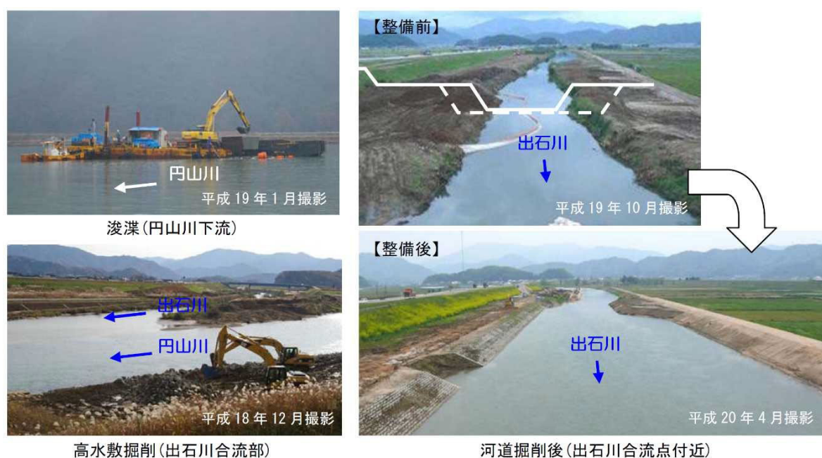
図 3-1 激特事業による河道掘削の状況
