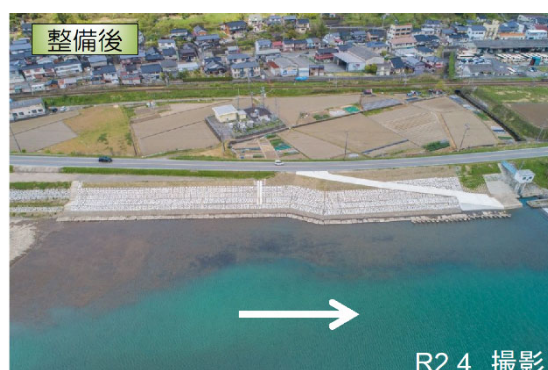
日高・八鹿工区 (整備後)
