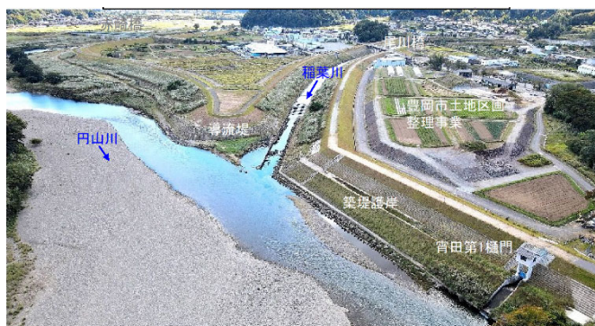
稲葉川合流点処理箇所（整備後）
