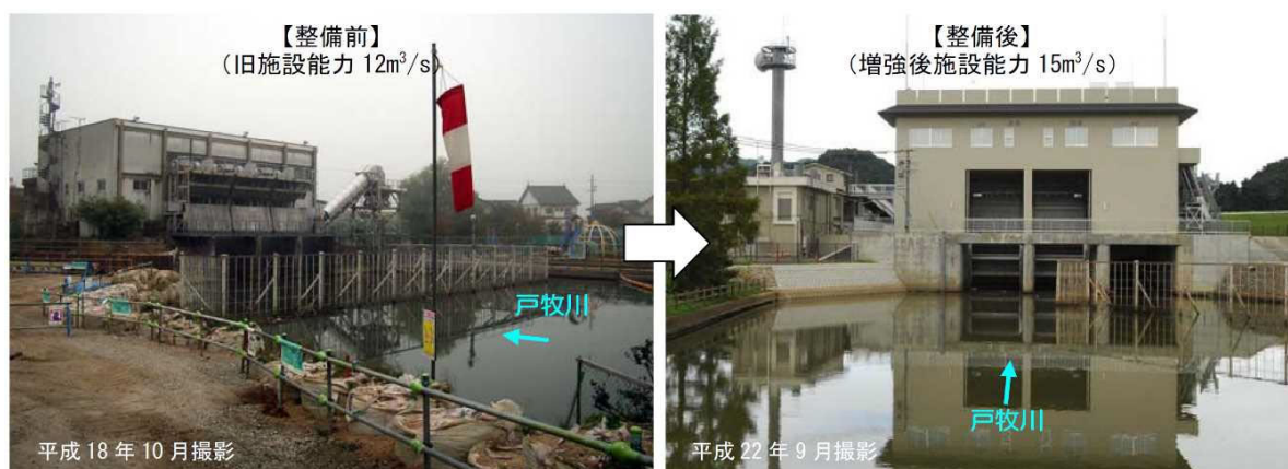
図 3-2 激特事業による豊岡排水機場の整備
