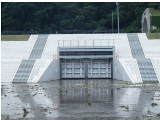
青山川樋門 (H27 年 6 月完成)
