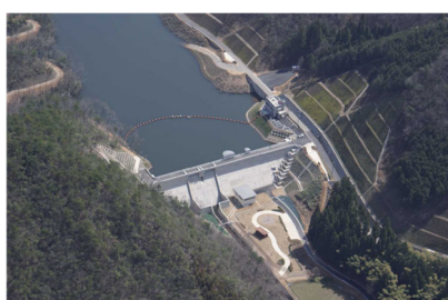
但東ダム（2006年（平成18）年完成）
