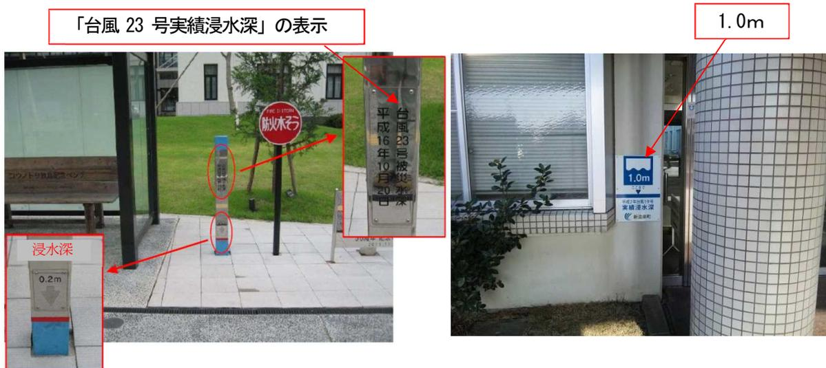
図 3-38 実績浸水深表示板の事例（自治体）
