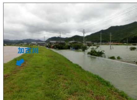
平成25年台風18号の浸水状況
