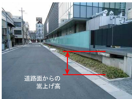
図 3-49 豊岡市役所の耐水化事例
