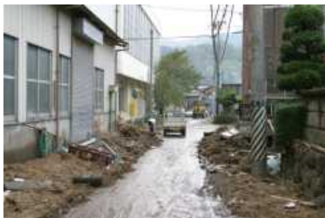
平成16年台風23号による被災状況
