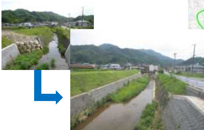
三谷川堤防嵩上げ [平成22年度完成]
