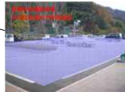
香美町役場駐車場貯留 [平成18年11月完成]
