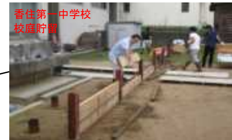
香住第一中学校校庭貯留・耐水化 [平成28年11月完成]
