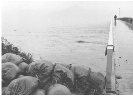
豊岡市塩津の 円山大橋付近の増水状況
