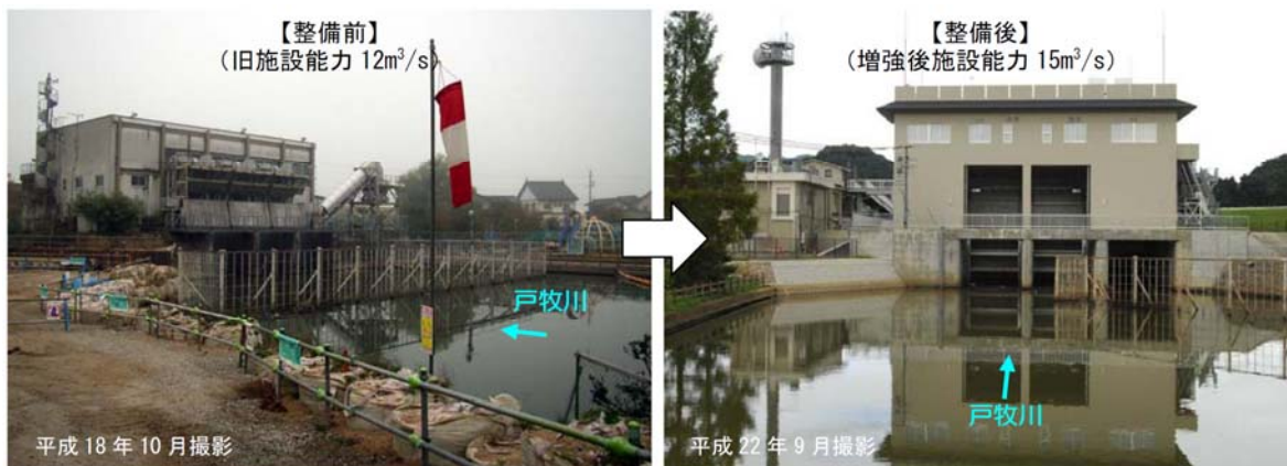
図 1.3.2 激特事業による豊岡排水機場の整備
