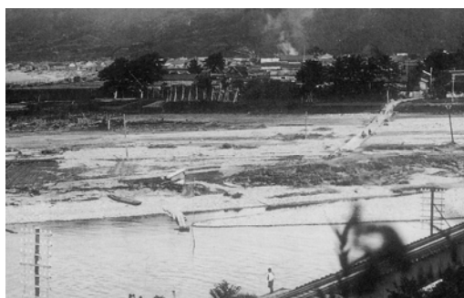
香住町（当時）の矢田橋付近の状況
