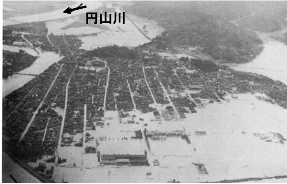
豊岡市 市街地中心部の浸水状況
