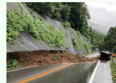
国道178号 台風豪雨による土砂崩れ
