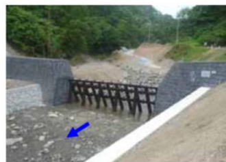
土砂・流木捕捉 透過型砂防えん堤（朝来市砂養）
