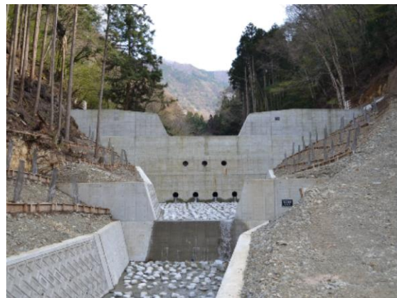
図 5.6.6 治山ダム さきのう の例（朝来市佐囊）
