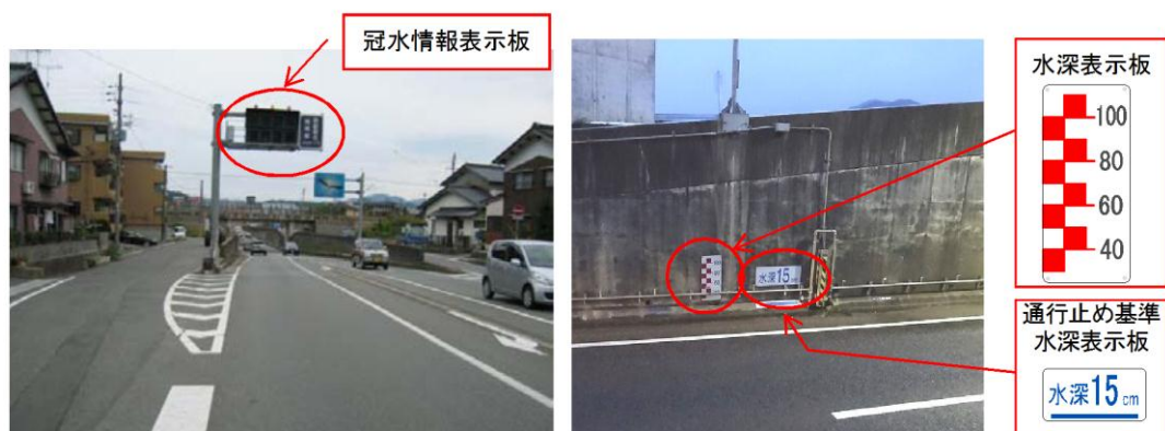
冠水情報表示板と水深表示板 (豊岡市 国道178号中陰架道橋 JR山陰本線アンダーパス) 図 6.2.8 道路アンダーパスの冠水情報板・水深表示板の例
