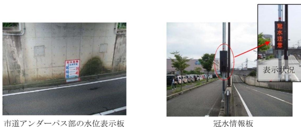
市道アンダーパス部の水位表示板 冠水情報板 図 6.2.9 豊岡市の市道におけるアンダーパスの冠水情報板・水深表示板の例 (市道 大開一日市線 西花園架道橋)
