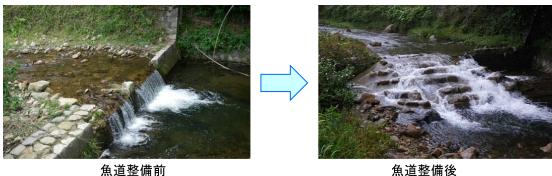
図 7.1.1 自然再生事業の事例（出石川の魚道新設事例）
