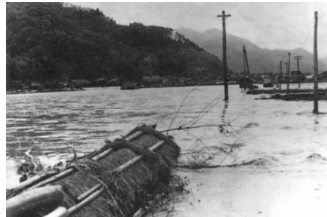
養父町（当時）大藪千石の円山川の 氾濫による農地の浸水状況
