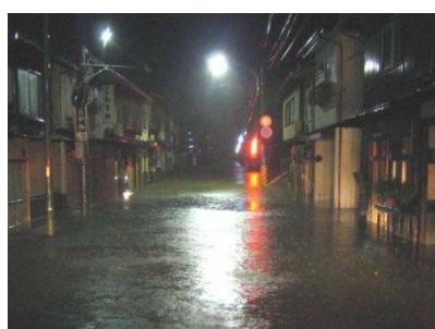
城崎温泉 湯島地区の浸水状況
