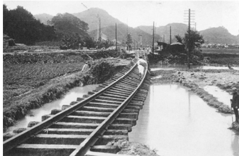
浜坂町（当時）の国鉄（当時）山陰本線 万ヶ崎信号所付近の岸田川水系田君川の状況
