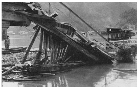
豊岡市小島の円山川河口付近の港大橋
