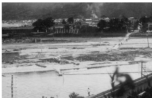
香住町（当時）の矢田橋付近の状況
