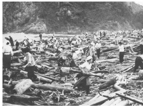
浜坂町（当時）の岸田川河口付近の流木散乱状況
