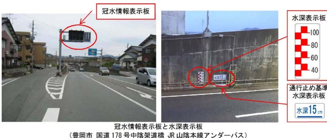
図 6.2.6 道路アンダーパスの冠水情報板・水深表示板の例
