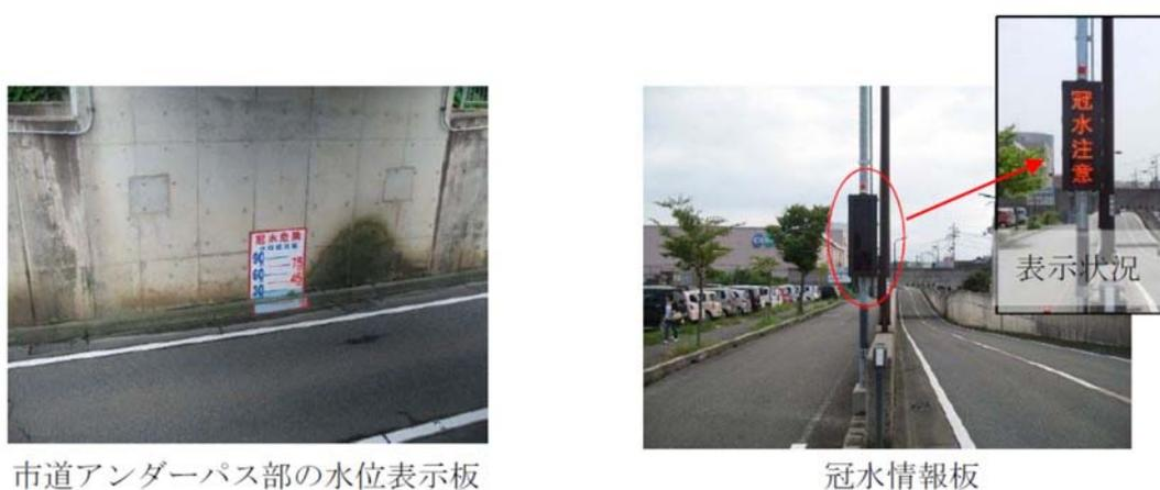
図 6.2.7 豊岡市の市道におけるアンダーパスの冠水情報板・水深表示板の例
