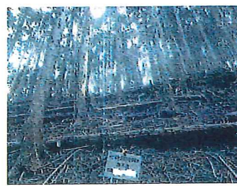
【緊急防災林整備事業施工後】
