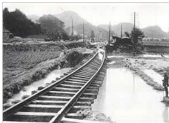
図 1.2.9 岸田川流域の昭和9年9月室戸台風洪水による被災状況 (旧国鉄山陰線 万ヶ崎信号所付近)
