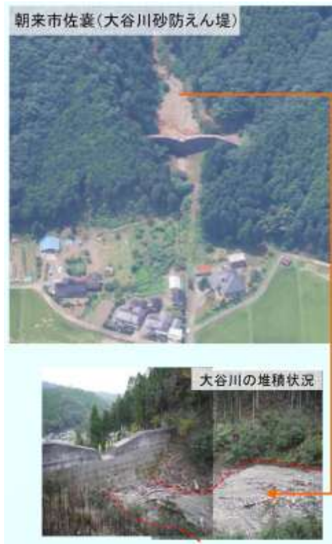
図 5.7.3 朝来市の大谷川砂防堰堤による土砂の捕捉状況（平成 21 年 8 月豪雨時）
