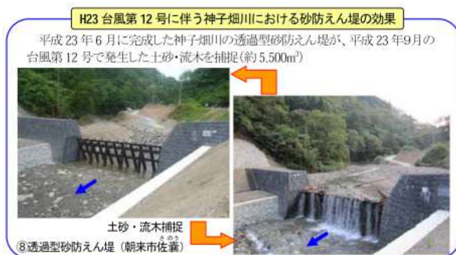
図 5.7.2 朝来市の神子畑川における砂防堰堤による土砂の捕捉状況（平成 23 年 9 月豪雨時）
