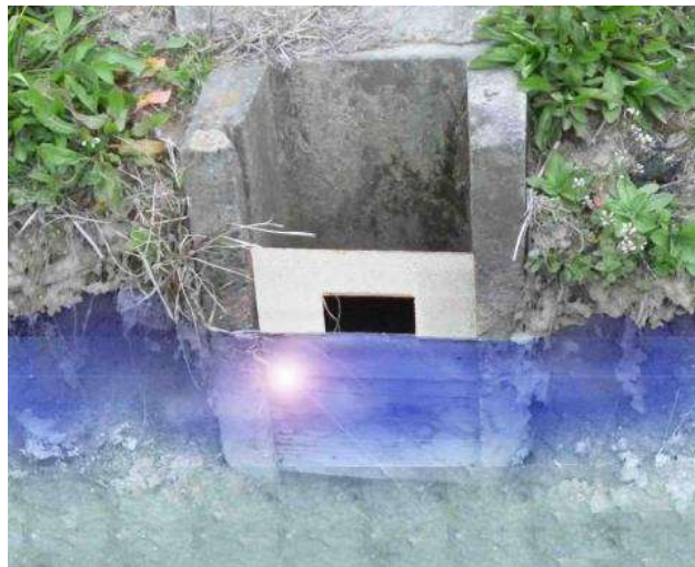
図 5.2.5 「田んぼダム」堰板設置イメージ（兵庫県ホームページより）
