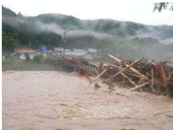
図 5.7.1 円山川上流域の神子畑川における流木による橋梁部の閉塞状況(平成 21 年 8 月豪雨時)
