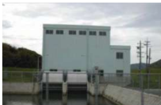
図 5.4.1 一日市排水機場（豊岡市、平成13年完成、国土交通省ホームページより）
