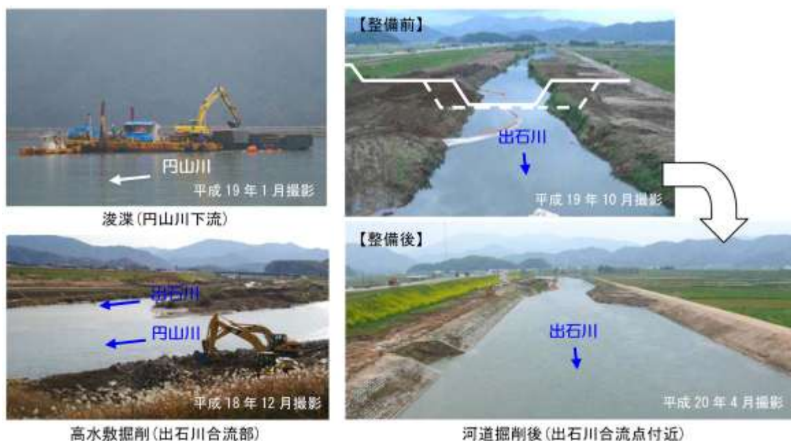
図 1.3.1 激特事業による河道掘削の状況
