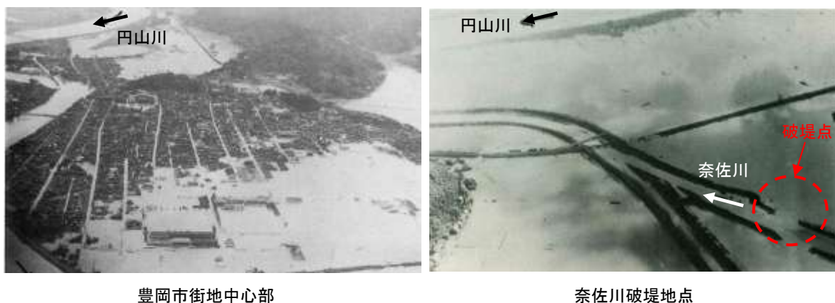
図 1.2.1 昭和 34 年 9 月洪水による円山川流域の浸水状況
