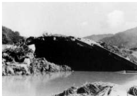
国道178号福田橋付近
