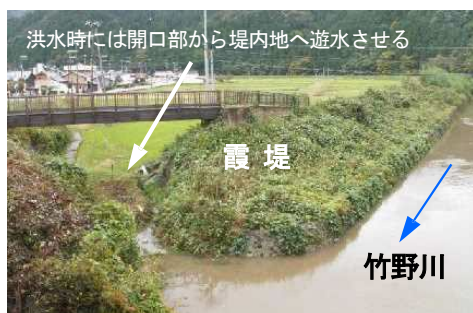
図 5-19 竹野川に現存する霞堤 (距離標 5k 付近)
