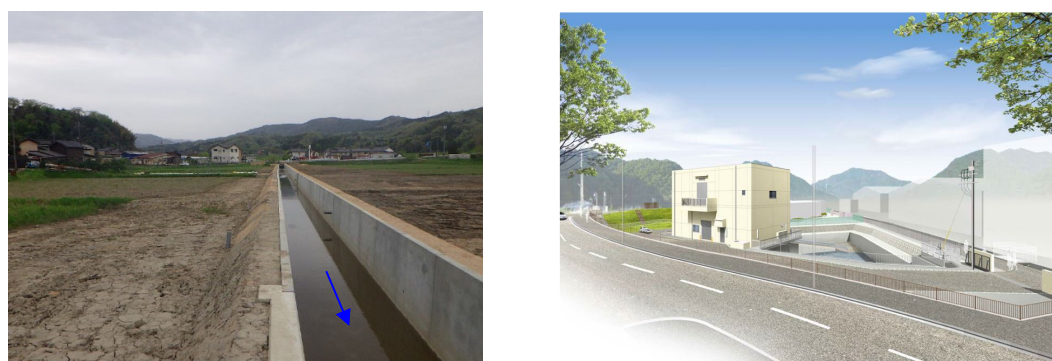
雨水幹線整備（豊岡市）
