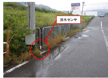
図 6-2 ワンコイン浸水センサーの設置・監視
