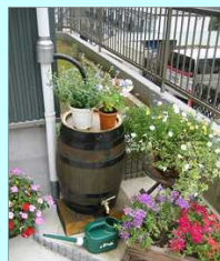
個人宅に設置された雨水タンク
