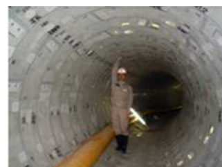
雨水貯留管 （左：西宮市 上：伊丹市）
