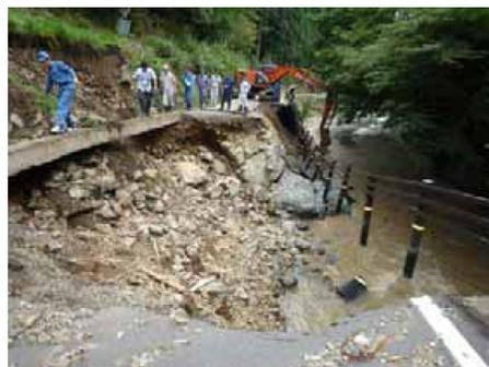
護岸崩壊による道路崩落箇所
