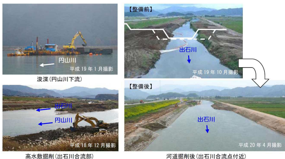
図 3-1 激特事業による河道掘削の状況
