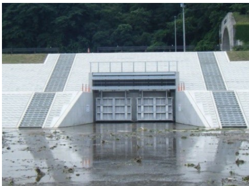
青山川樋門 (H27 年 6 月完成)
