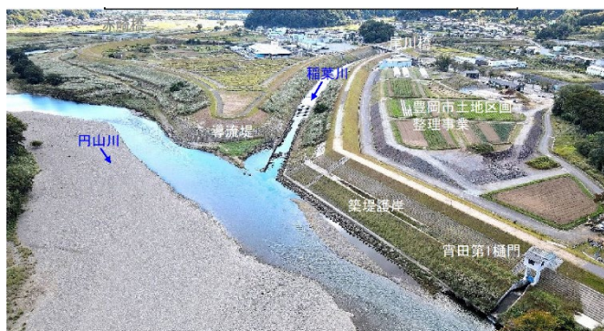
稲葉川合流点処理箇所（整備後）
