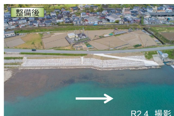
日高・八鹿工区 (整備後)
