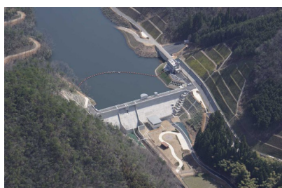
但東ダム（2006年（平成18）年完成）
