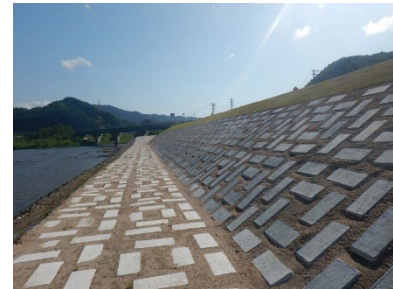
完成断面図 (近景)
