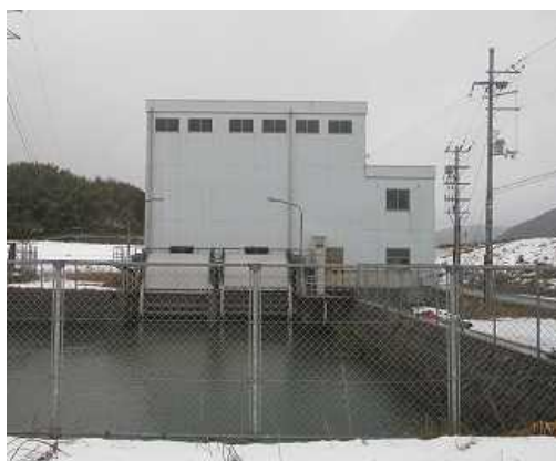
図 3-27 一日市排水機場（豊岡市、2001（平成13）年完成）
