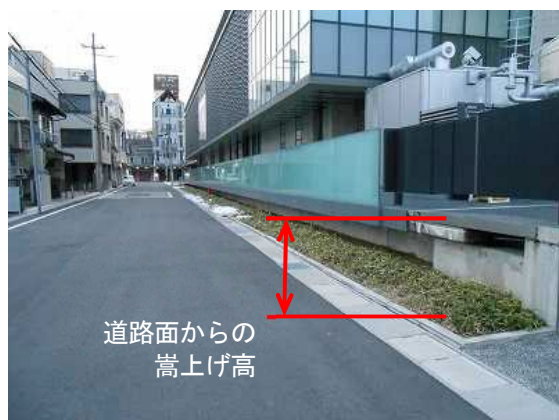
図 3-49 豊岡市役所の耐水化事例
