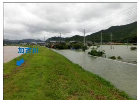
平成25年台風18号の浸水状況
