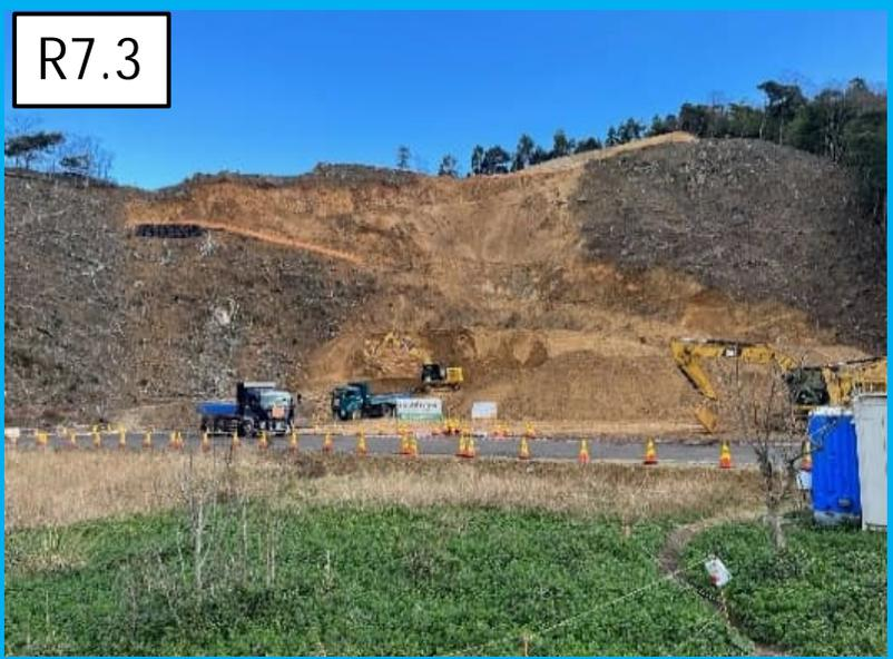
枋谷では法面8段中、上2段の掘削が完了しました。
