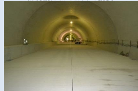
新桃観トンネルのコンクリート舗装
