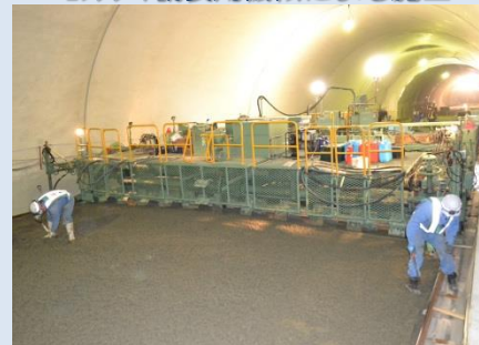
コンクリート舗装用機械による施工
