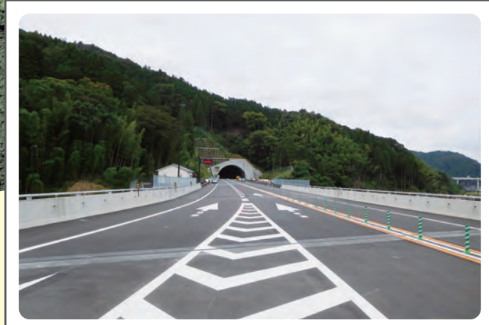
アセビ橋・あまるべトンネル
