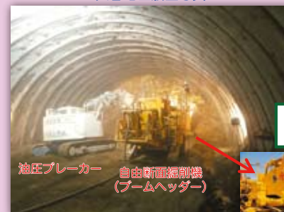
工事状況（トンネル掘削作業中）
