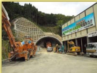
工事状況（東側坑口付近）
