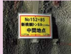
中間地点に設置した標示板
