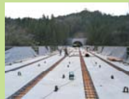
完成間近の久谷第2トンネルと瀬間大橋
