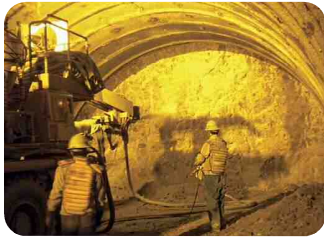
④1次吹付コンクリート
