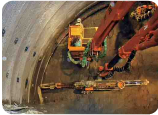
⑦ロックボルト打設
