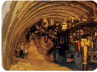
⑤支保工建て込み
