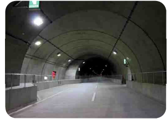
⑨覆工(完了)
