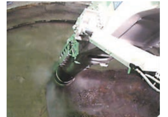
自由断面掘削機掘削状況
