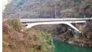
場所：福岡山一尾 橋の長さ：50m
