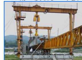
PC桁の横取り・架設
