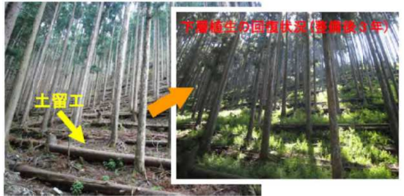
間伐木を利用した土留工整備事例(養父市)
