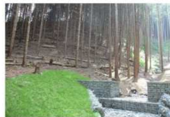
写真：溪流沿いの間伐及び簡易防災施設
