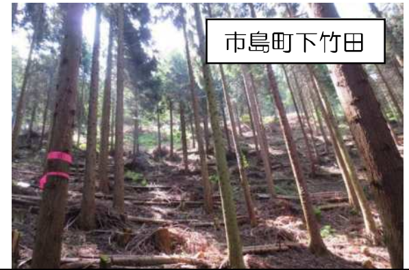
簡易土留め工による表土侵食防止対策
