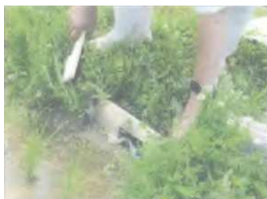
田んぼダム「セキ板」設置作業
