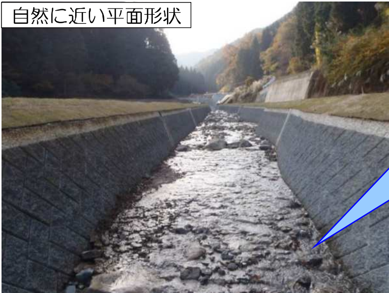
緩傾斜落差工
