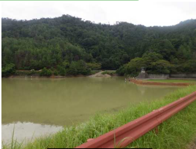
(大杉ダム) 着工前
