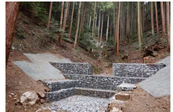
鋼製かご枠による簡易防災施設(例)
