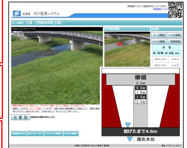
河川監視システム
