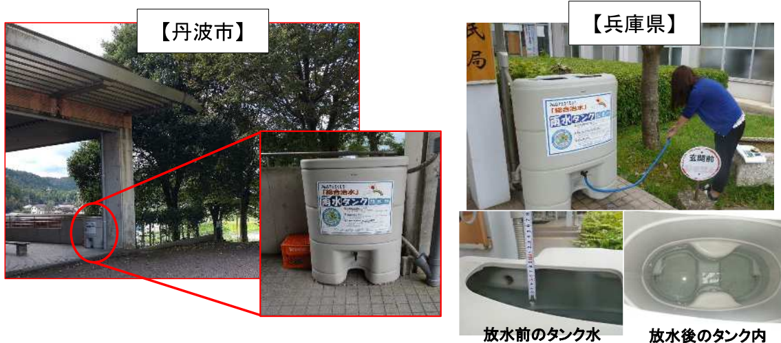
図 5-5 雨水貯留タンクの取組事例
