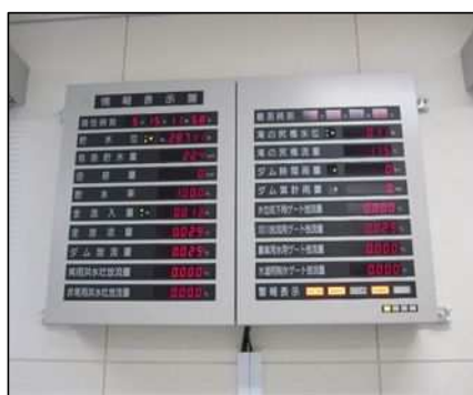
図 4-2 ダム管理用制御処理設備等の更新
