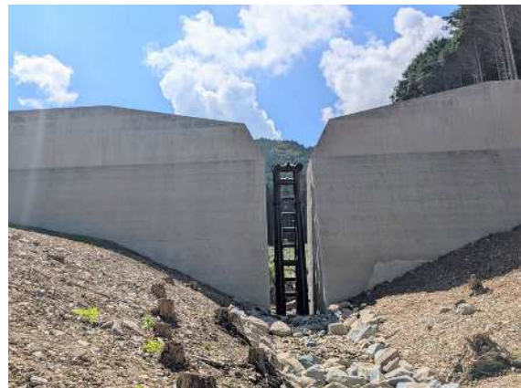
砂防えん堤（事例）
