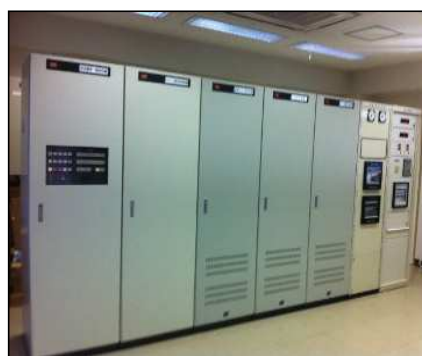
図 4-2 ダム管理用制御処理設備等の更新
