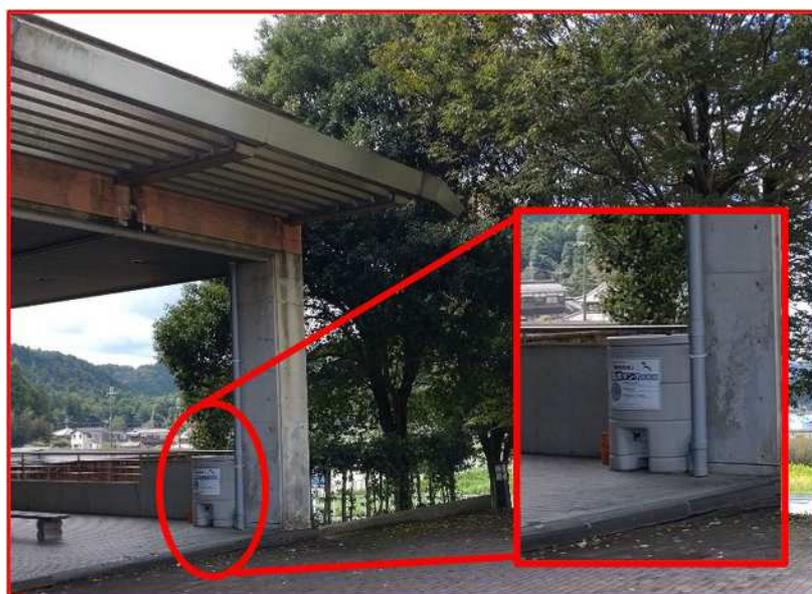
図 3-5 雨水貯留タンク【ライフピアいちじま】
