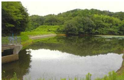
図 5-14 ため池の治水活用状況（期間放流による水位低下）
