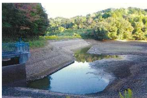
図 5-14 ため池の治水活用状況（期間放流による水位低下）
