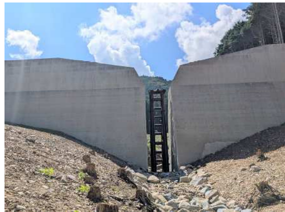
砂防えん堤（事例）
