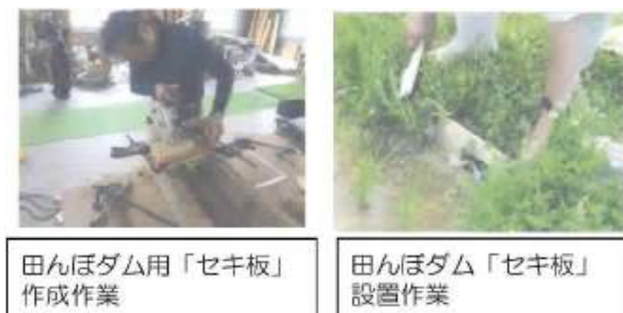
図 3-6 田んぼダム作成・設置状況
