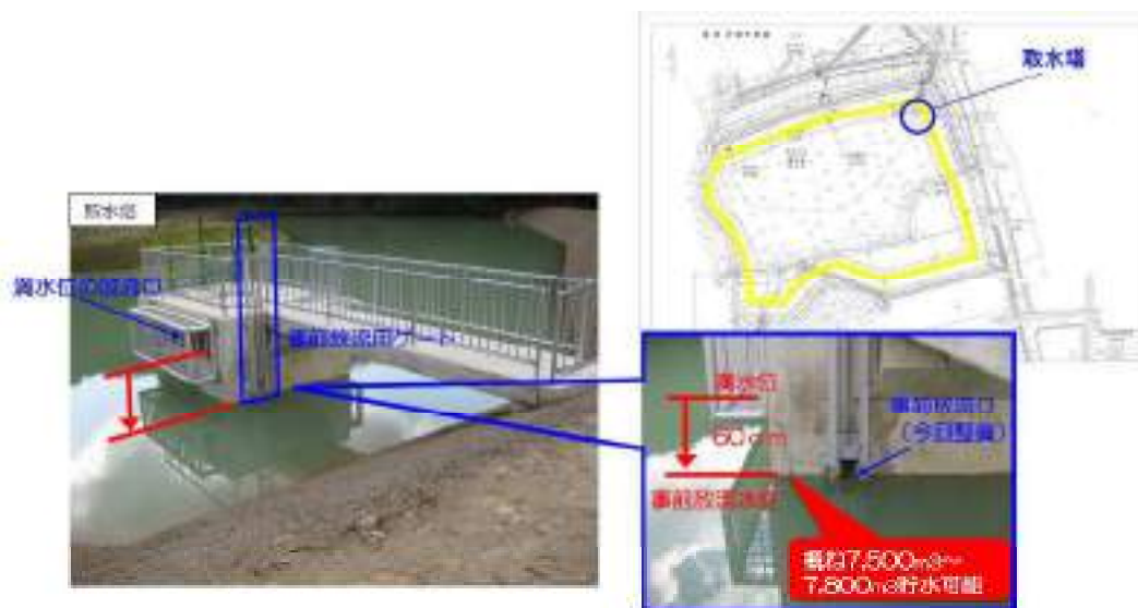
図 3-9 期間放流用ゲートの整備（奥の谷古池）
