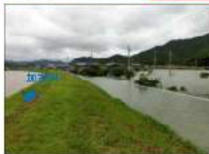
平成25年台風18号の浸水状況
