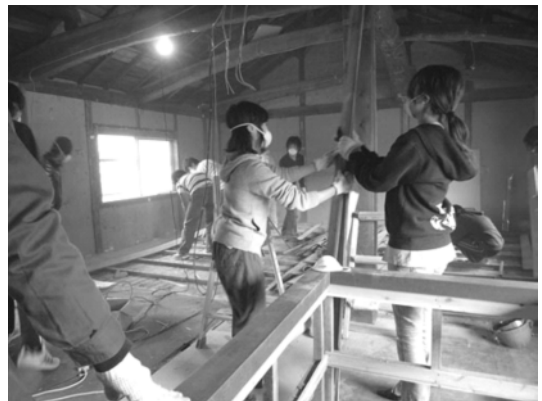
学生たちによる空き家改修の様子
