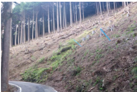
工事現場の状況
