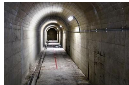
三宝ダム管理トンネル内
