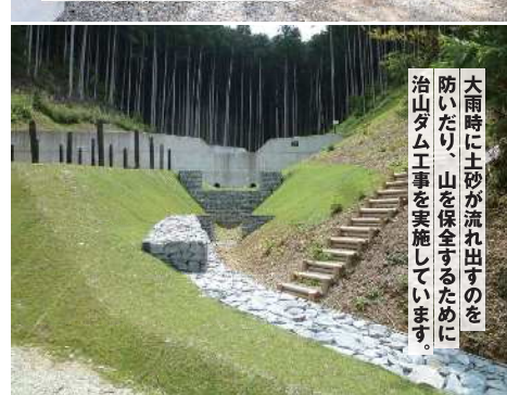
県と市町合同で治山ダムを点検しています。
