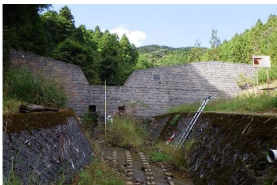
① しもおはら 下小原川砂防堰堤
